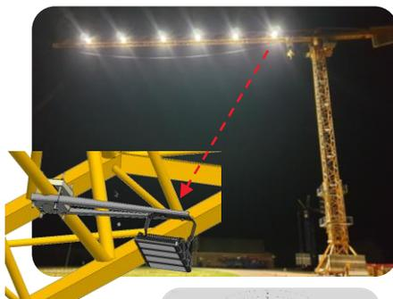
Nous avons la possibilité de simuler l'éclairage de votre chantier par logiciel pour optimiser le nombre de projecteurs nécessaires.
