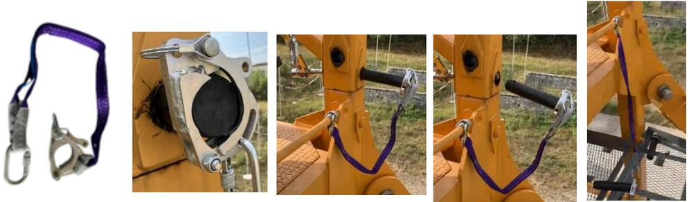
Ce système verrouillable prévient les risques de chute d'axes lors du démontage de la grue
