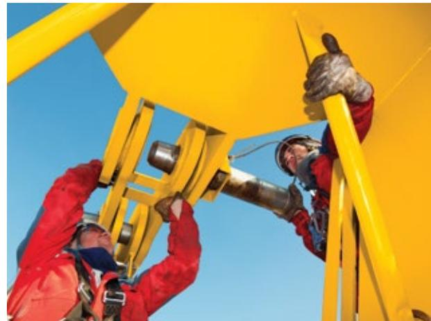
^ Für das Einpassen und Verbolzen des Auslegers am A-Bock wird nur ein Bolzen benötigt.
